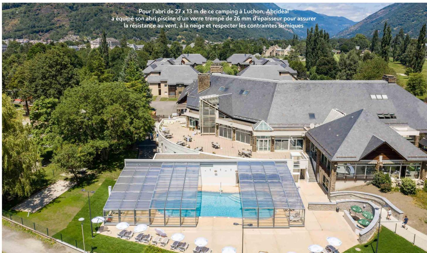
Pour l'abri de 27 x 13 m de ce camping à Luchon, Abridéal a équipé son abri piscine d'un verre trempé de 26 mm d'épaisseur pour assurer la résistance au vent, à la neige et respecter les contraintes sismiques
